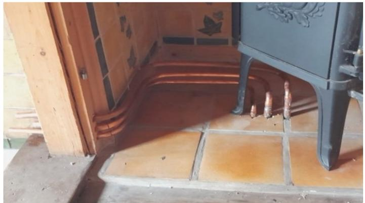
Les batteries doivent en priorité alimenter un circuit pour chauffer l'eau, qui passe par le fourneau.
